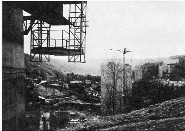
Vue d'ensemble. Etat d'avancement des travaux en mars 1979
