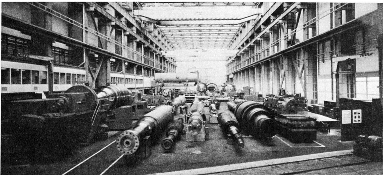
Bild 4 Innenansicht der Halle
