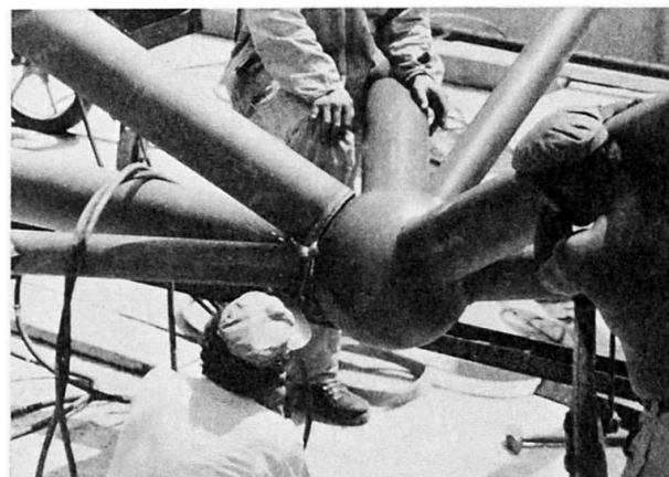
Fig. 4 Sphère de liaison entre bégueille et traverse
