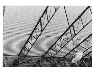
Fig. 6 Fermes à treillis de la piscine
