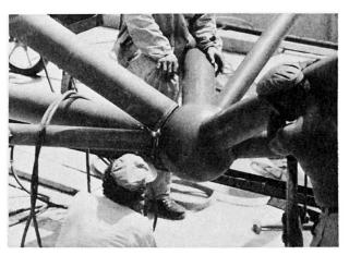
Fig. 4 Sphère de liaison entre béquille et traverse
