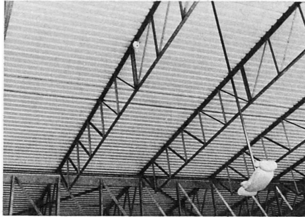
Fig. 6 Fermes à treillis de la piscine
