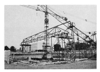
Fig. 5 Pose de la traverse d'un portique transversal
