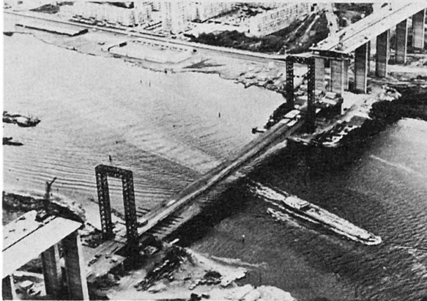
Levage de l'ensemble du tablier
