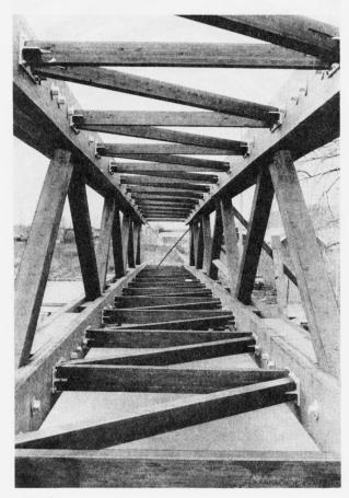
Bild 4: Ausbildung der Fachwerkriegel mit den Aussteifungsverbänden Bild 5: Endauflager mit Rahmenstiel und Windverband
