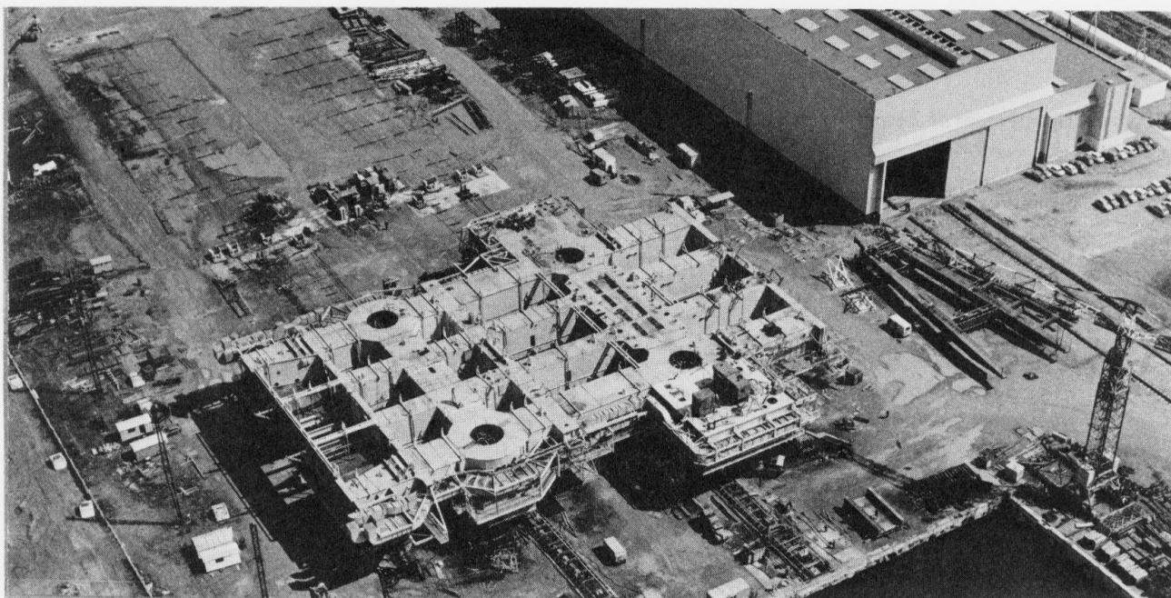
partir de ces éléments. L'assemblage se termina par les quatre pièces de transition pesant chacune 125 tonnes. Parallèlement, l'installation des équipements intérieurs déjà commencée au sol fut terminée. Les équipements extérieurs comprenant passerelles, gaines, tuyauteries, poutraisons devant supporter les pallets, guides devant servir pour la mise en place de ces pallets et des modules furent installés.
