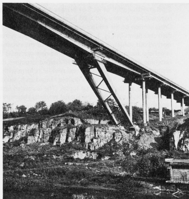
Fig. 7 Une partie de la travée centrale avec des béquilles
