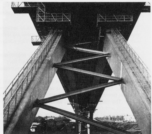
Fig. 2 Vue par dessous
