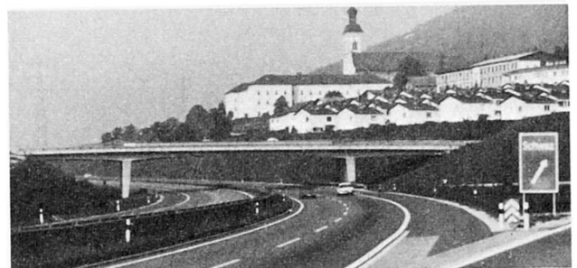
Bild 5 Inntalautobahn Kreuzungsbauwerk Schwarz (1968)
