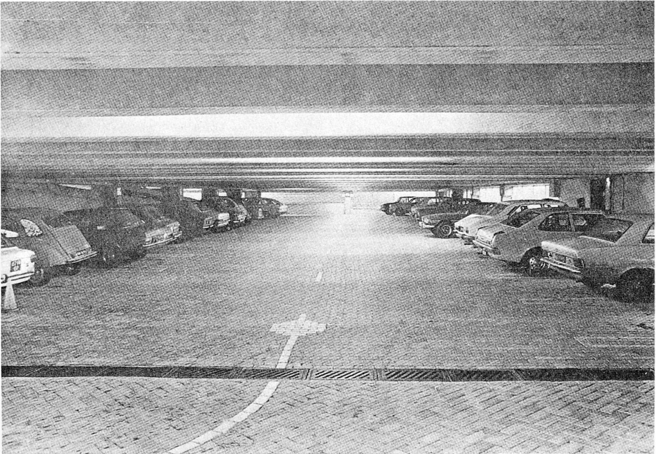
Der stützenfreie Parkraum ist gut übersichtlich und ermöglicht bequemes Einparken
