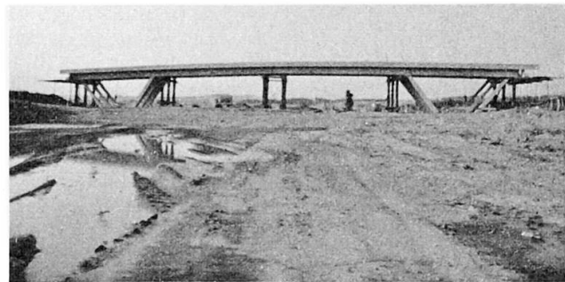
Fig. 5 Ansicht Montagezustand
