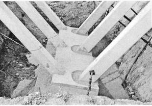
Fig. 6 Fundament mit V-Stielen
