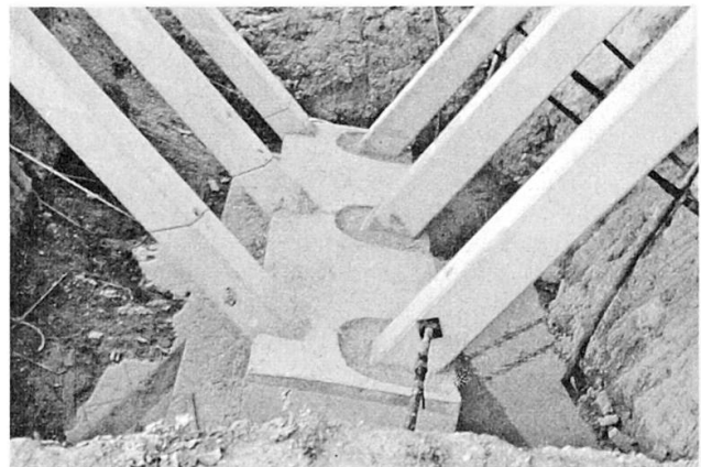
Fig. 6 Fundament mit V-Stielen
