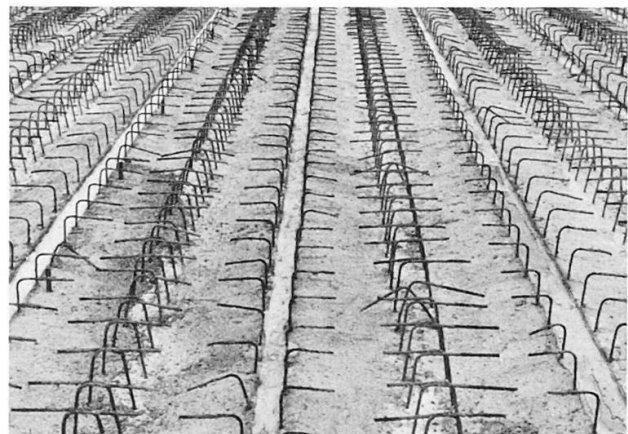
Bild 6: Fotografie der Verbundbügel zwischen Ortbeton und Fertigteilen
