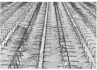
Bild 6: Fotografie der Verbundbügel zwischen Ortbeton und Fertigteilen
