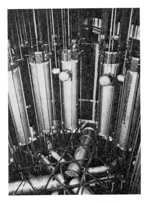
Fig. 3. Vue de l'intérieur du modèle lors de la pose des cavités et câbles de précontrainte.
