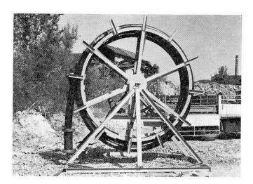
Fig. 31. Auf Haspel aufgewickeltes Paralleldrahtkabel aus 211 Drähten Ø 7 mm durch Polyäthylenrohr für Transport und Montagezeit geschützt.
