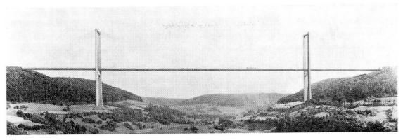
Fig. 48. Entwurf für eine hohe Talbrücke mit  $l=620~\mathrm{m}$ .
