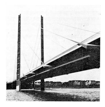
Fig. 40. Konsolen zur Aufhängung der Kniebrücke Düsseldorf.
