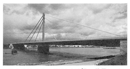
Fig. 37. Rheinbrücke Maxau, Mittelträgerbrücke (Entwurf L. Wintergerst).
