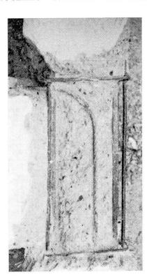
Fig. 36. Etat de la colonne métallique d'un nœud enrobé après la mise hors service.
