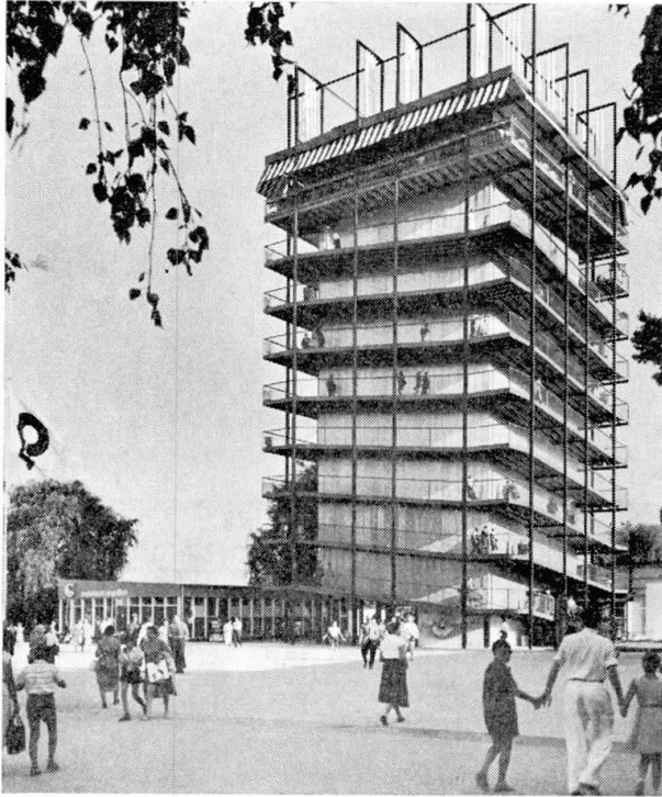
Fig. 6. Ausstellungsturmhaus der SAFFA, Zürich. Unverkleidete Stahlkonstruktion.
