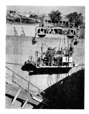
Fig. 35. Précontrainte horizontale d'un réservoir.
