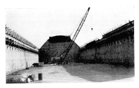
Fig. 33. Corbeaux d'appui des coffrages glissants. On voit les fers en attente des articulations des arcs.
