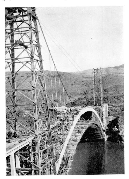
Fig. 14. Démontage du cintre du pont de Pertek.
