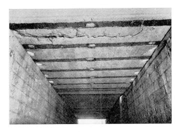
Fig. 11. Tablier après essais, vu de dessous.
