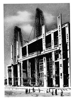
Fig. 6. Aus Säulen- und Balken-Elementen vorgefertigte Hallen-Konstruktion.
