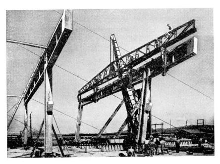
Fig. 5. Montierung der liegend vorgefertigten Rahmen.
