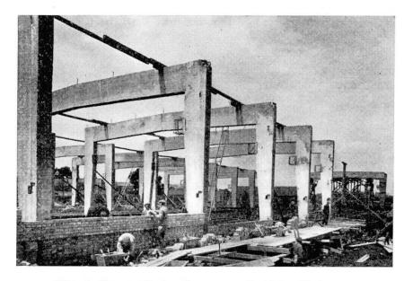
Fig. 4. In vertikaler Lage vorgefertigter Rahmen.
