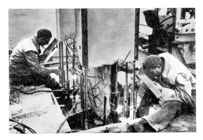
Fig. 17. Schweißen der Stahleinlagen der unten eingespannten Säulen.
