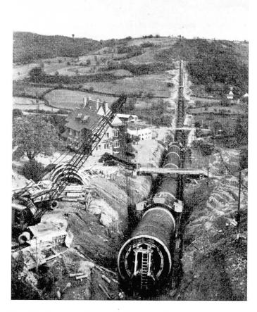
Fig. 16. Vue générale de la conduite avant gunitage.
