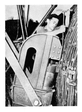
Fig. 14. Vérin hydraulique.
