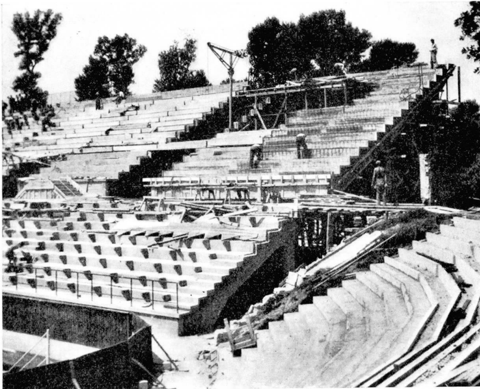
Fig. 2. Wiener Stadionbad. Stahlbetontribüne beim Sportbassin im Bauzustand. Verlegung der Stahlbeton-Fertigteilstufen
