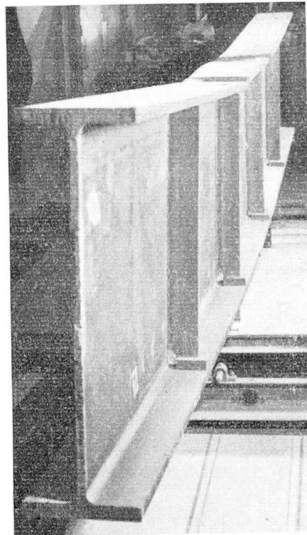
Photo 2. Poutre IV c
