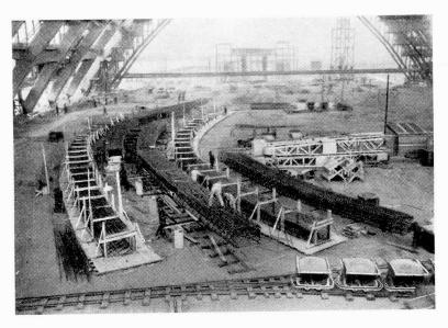
Fig. 17. Vorbereitung der Bogenarmierungen auf Arbeitsbühne am Boden. Man sieht die aufeinanderfolgenden Teile der Bewehrungen.
