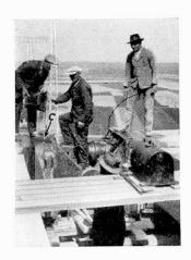
Fig. 20. Kurz nach dem Ausrüsten; Ausbetonieren der Scheitelfuge.
