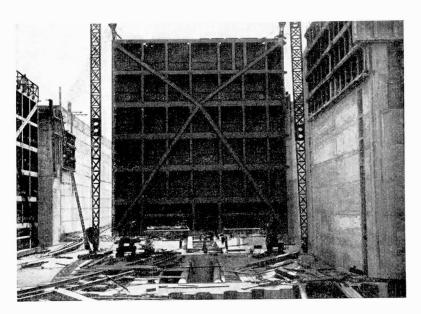
Fig. 10. Geschweißtes Schleusentor in Wynegem. Porte soudée de l'écluse de Wynegem. Welded lock gates at Wynegem.
