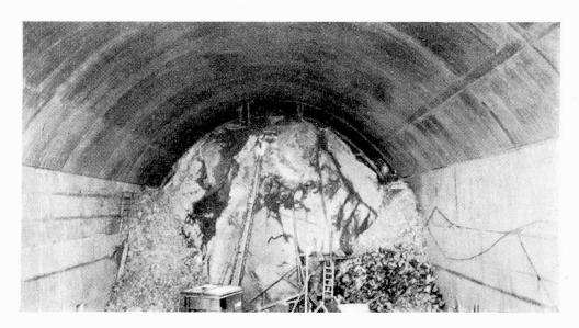
Fig. 10. San Francisco-Oakland Bay Bridge. Kern-Aushub im Yerba Buena Tunnel. Profil définitif du tunnel de Yerba Buena. Final excavation for Yerba Buena Tunnel.
