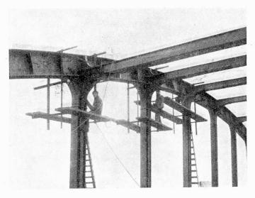
Fig. 5. Pont "C" à Hérenthals. Soudure au montage. — Schweißen während der Montage. — Welding during erection.
