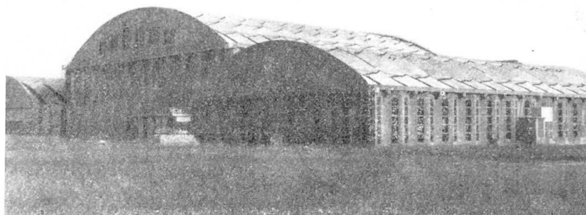
Fig. 23. Voûtes 50 m et 30 m. Voiles gauches épaisseur 0,06 m. Regelschalengewölbe von 50 und 30 m Spannweiten und 6 cm Dicke. Skew surface vaults of 30 and 50 m span; 6 cm thick.
