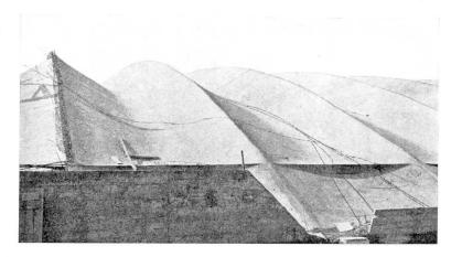
Fig. 25. Voûtes gauches de 50 m de portée, épaisseur 0,05 m. — Regelschalengewölbe von 50 m Stützweite und 5 cm Dicke. — Skew surface vaults of 50 m span, 5 cm thick.
