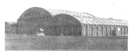
Fig. 23. Voûtes 50 m et 30 m. Voiles gauches épausseur 0,06 m. Regelschalengewölbe von 50 und 30 m Spannweiten und 6 cm Dicke. Skew surface vaults of 30 and 50 m span; 6 cm thick.
