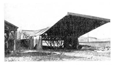
Fig. 27. Double duvent gauche. — Doppeltes Schutzdach als Regelfläche. — Cantilevered twin roofs with skew surface.
