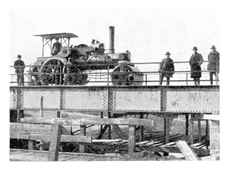
Fig. 1. Brücke über den Gaka Bach in Ungarn. Probebelastung. Pont sur la rivière Gaka, Hongrie — Charge d'épreuve. Bridge over the Gaka, Hungary. Test loading.
