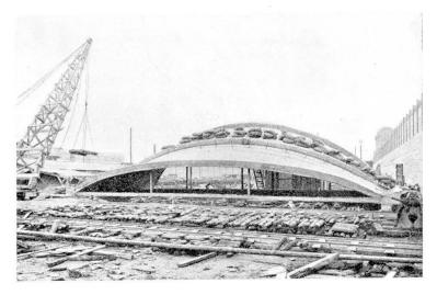
Fig. 3. Vue de le voûte d'essai au début du chargement. — Ansicht der Versuchsschale zu Beginn der Belastung. — View of test shell at beginning of loading.
