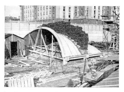
Fig. 5. Vue de la voûte au cous du deuxième essai. — Ansicht der Schale im Verlauf des zweiten Versuches. — View of shell during 2nd test.
