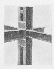
Fig. 10. Socle soudé à l'autogène — Autogen geschweißter Unterzugskopf — Autogenous Welded Girder Bearing.
