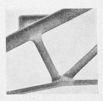
Fig. 11. Ferme en fers à T et en tuyaux, soudée - Dachbinder, aus T-Eisen à l'autogène und Rohren autogen geschweißt - Roof Girder of T-Iron and Tubes, Autogenous Welding.
