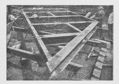
Partie d'un pont soudéà l'autogène (Hambourg).
