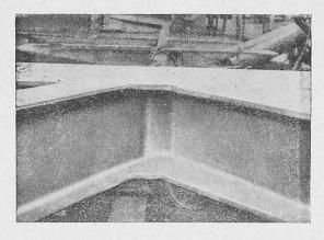
Noeud d'un pont soudé à l'autogène (Cologne).
