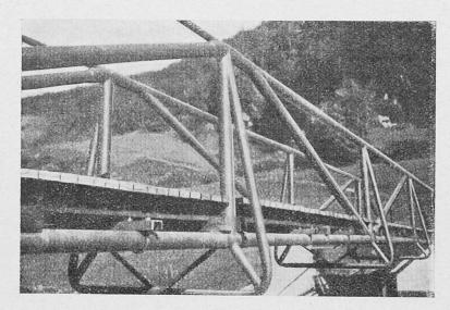
Passerelle tubulaire soudée à l'autogène (Tyrol).
