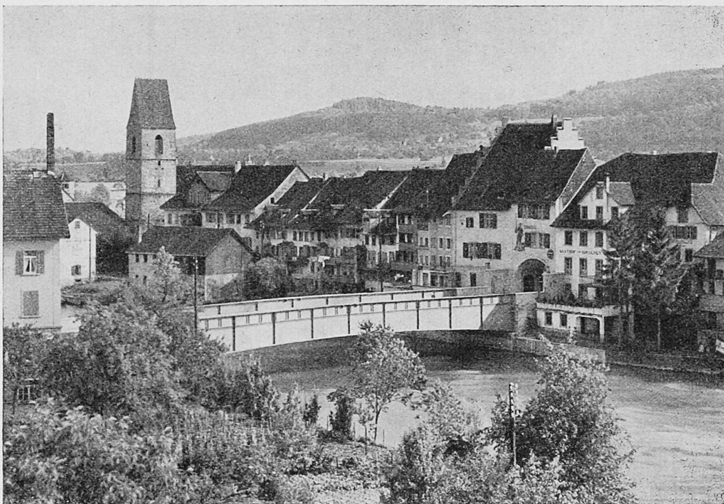
Fig. 1. Pont-route sur la Reuss à Mellingen.
