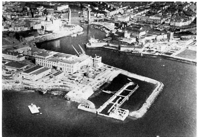
Finition de la digue d'enclôture du terre-plein après échouage du bassin et adjonction d'un caisson de quai.
