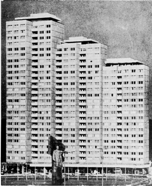
Bild 6 Wohnhochhaus mit 24 Geschossen in Platten- bauweise /50/
