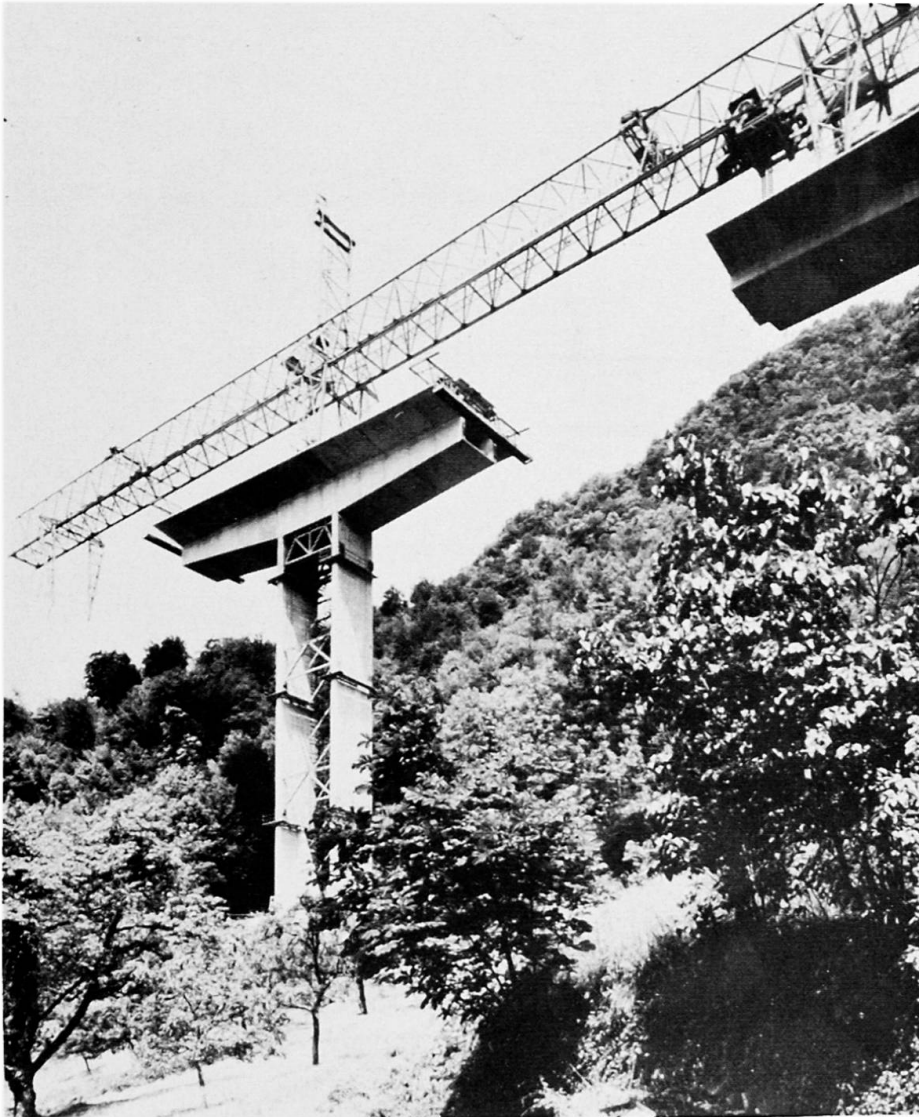
Bild 15. Viaducs de Chillon. 10) Nationalstrasse N9 Lausanne - Sion (Foto Germond, Lausanne)
