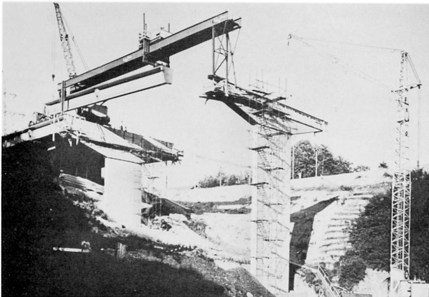
Bild 10. Bünzthal-Brücke, Nationalstrasse N1 Zürich - Bern
