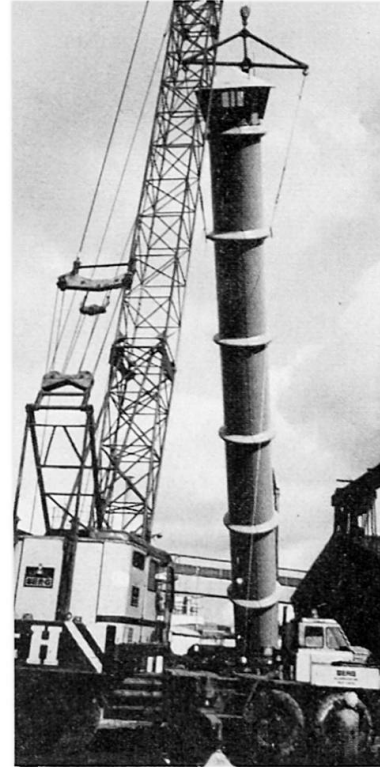
Montage des GFK-Ansaugkamines, Abb. 11
