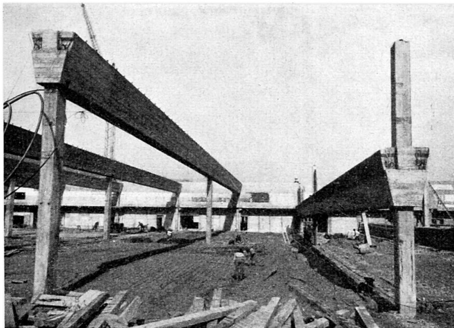
Abb. 5 - Am Boden vorgefertigte Träger von mehreren 100 to Gesamtgewicht werden mittels simultan arbeitenden hydraulischen Pressen auf provisorische Stahlstützen gehoben. Ingenieur: E. Wälli, Rorschach. Hebesystem: Hebag AG für rationelles Bauen, Tübach SG.
