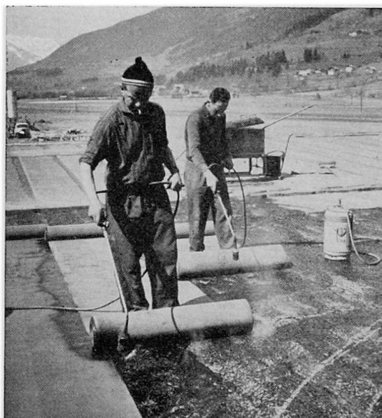
Fig. 1. Bitumen-Isolierungen nach dem Flämmverfahren.
