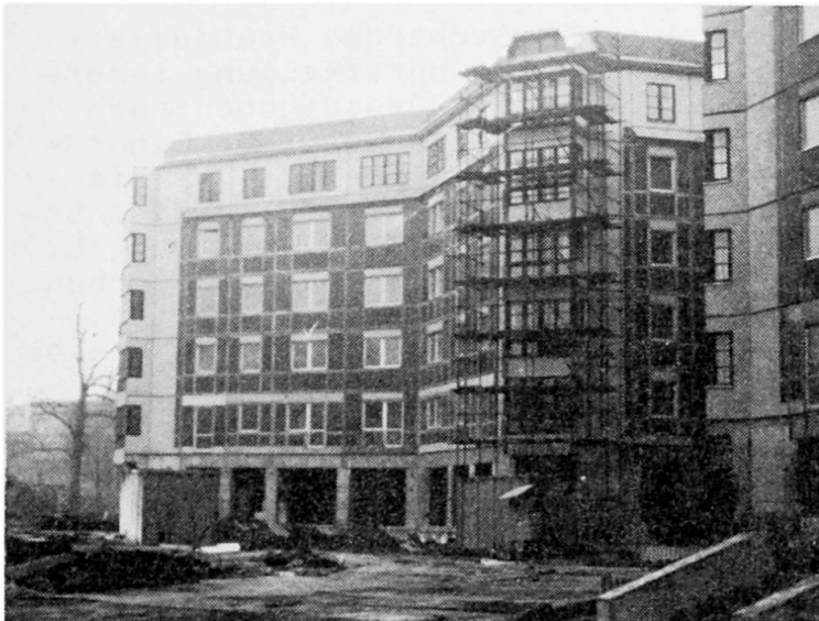
Bild 3 Unterlagerung eines Wohngebäudes in Plattenbauweise durch ein monolithisches Erdgeschoß
