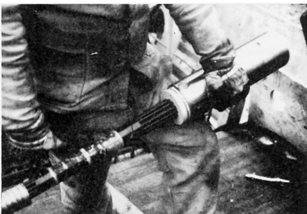
Abb. 6: HLV-Spannglied mit 19 Stäben
