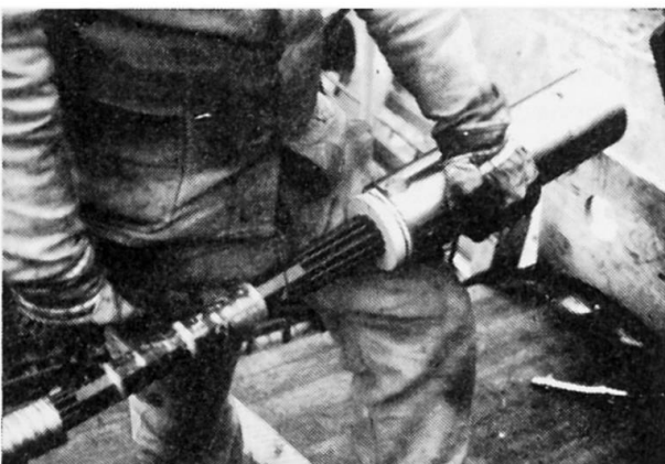
Abb. 6: HLV-Spannglied mit 19 Stäben
