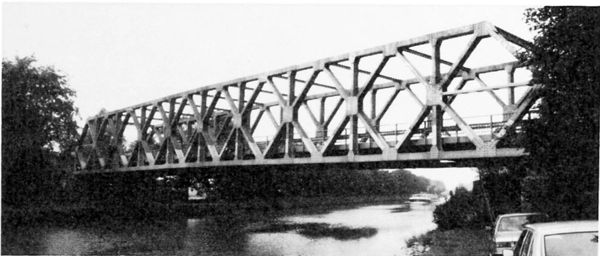
Fig. 1 Untersuchte genietete Fachwerk-Straßenbrücke
