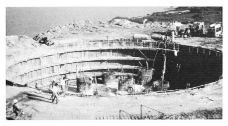
Figure 5: Fondations des piles principales
