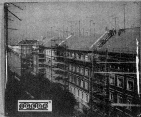
Reko-Taktstraße mit industriellem Gerüstbau Teamarbeit VEB KBR und TH Leipzig Foto: L.B.Hoppe
