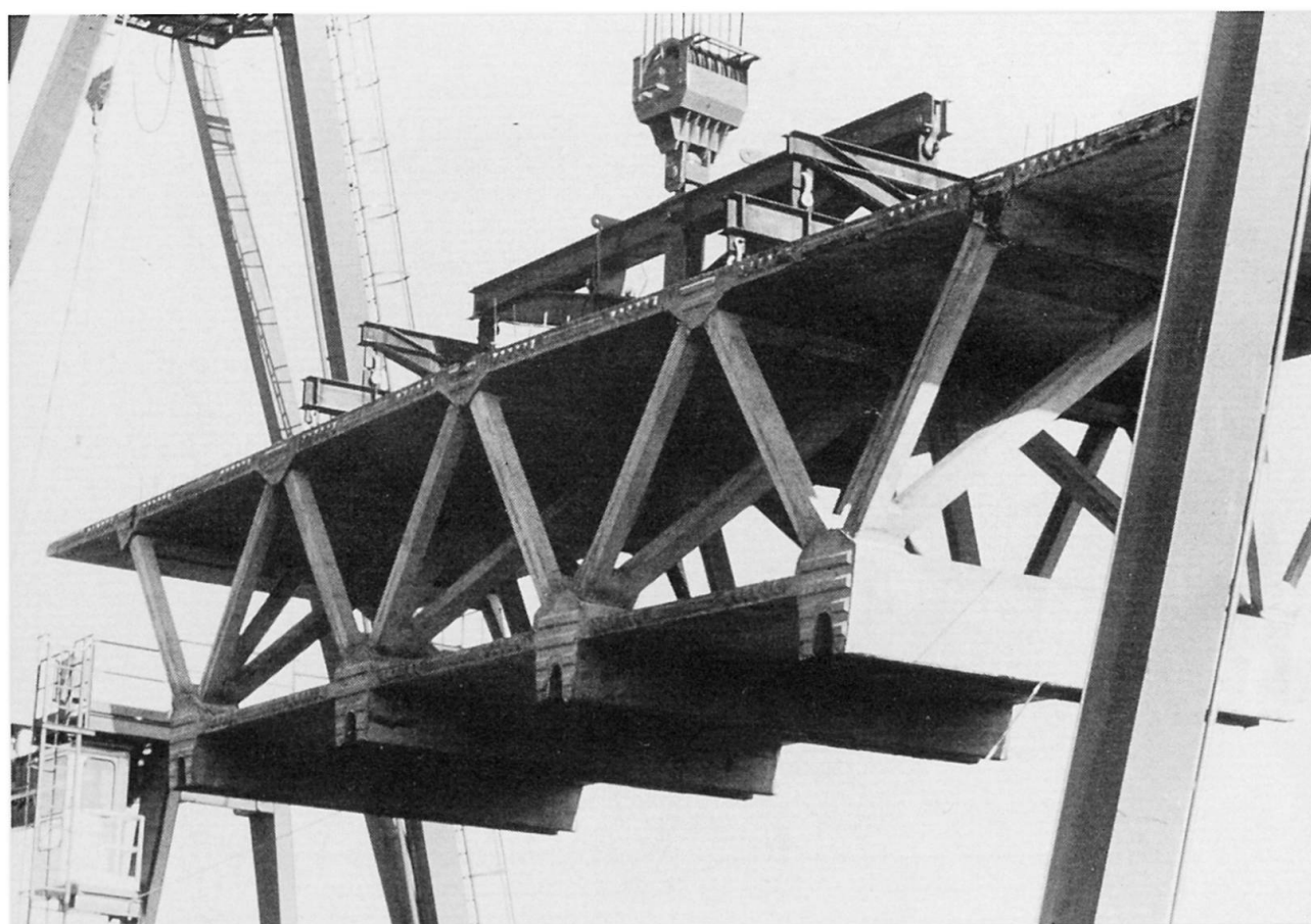
Figure 1 – Manutention d'un voussoir préfabriqué du pont de BUBIYAN
