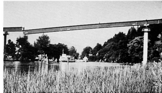
Herstellung des natürlichen Momentenverlaufes durch Absenken und Verbinden mit den anliegenden Teilen
