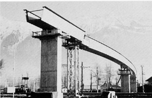
Zusammenschluss mit vorgängig versetztem Element
