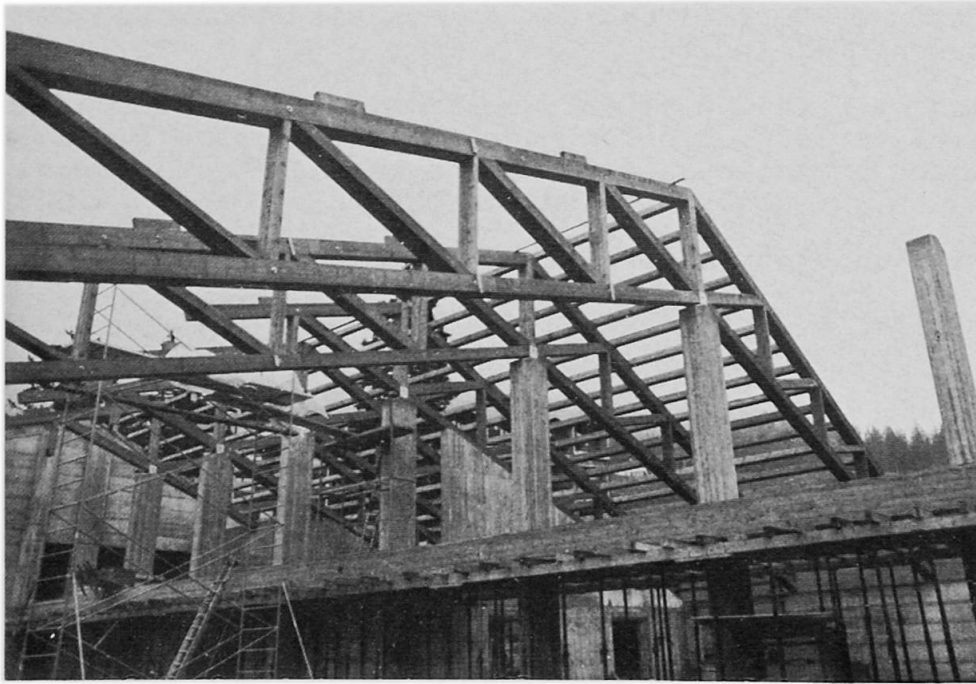
Bild 3 Fachwerkbinder für Hallenbad (13 und 15 m)
