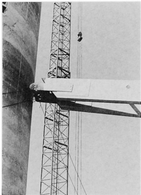
Bild 5: Anschlussdetail eines Dachsegments im Auflagerbereich des Turmes
