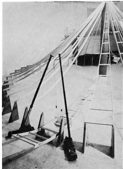
Bild 6: Am Montagemodell (1:50) lässt sich die Struktur des Hängerippen-daches (abgewickelte Fläche: ca. 29000 m<sup>2</sup>) ablesen
