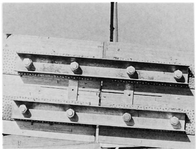
Bild 4: Ausbildung der biegesteifen Stöße mit vollausgenagelten Blechen sowie Gelenkbolzverbindungen
