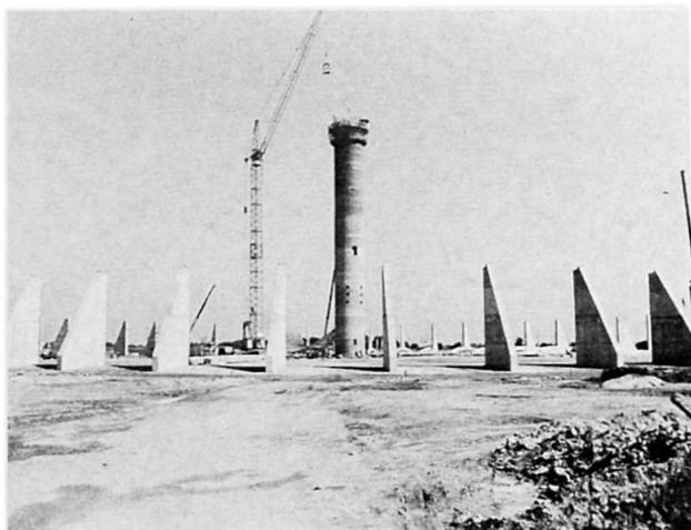
Bild 1: Vom turmhohen Firstpunkt (Endhöhe 67 m) bis zu den im Kreis angeordneten scheibenförmigen Betonaufplägern (Traufhöhe 11 m) werden die 48 Hängerippen eine freie horizontale Spannweite von 82 m überbrücken
