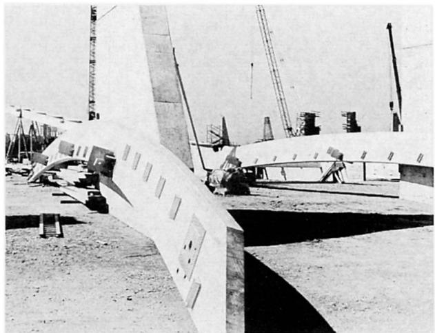
Bild 2: Mit den erforderlichen Anschluss- und Stoßverbindungen versehen, werden auf der Baustelle jeweils 3 Brettschichtelemente zu einer 102 m langen Hängerippe montiert
