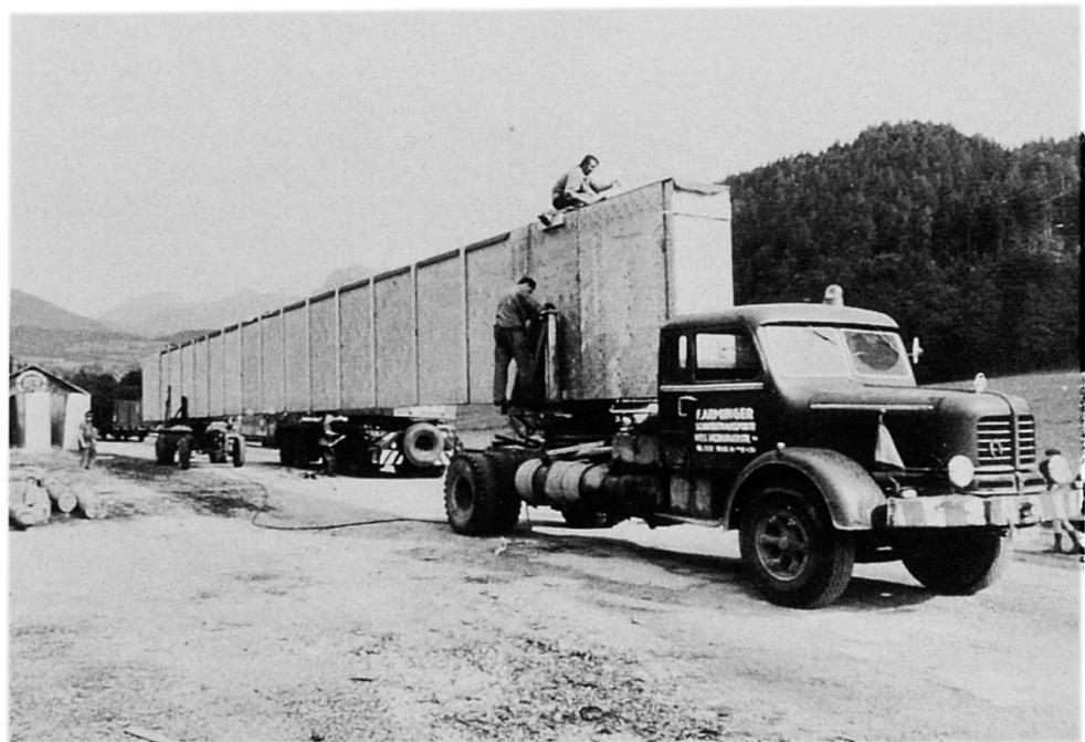
Bild 10: Straßentransport von 32 m langen Kastenträgern mit Sperrholzstegen
