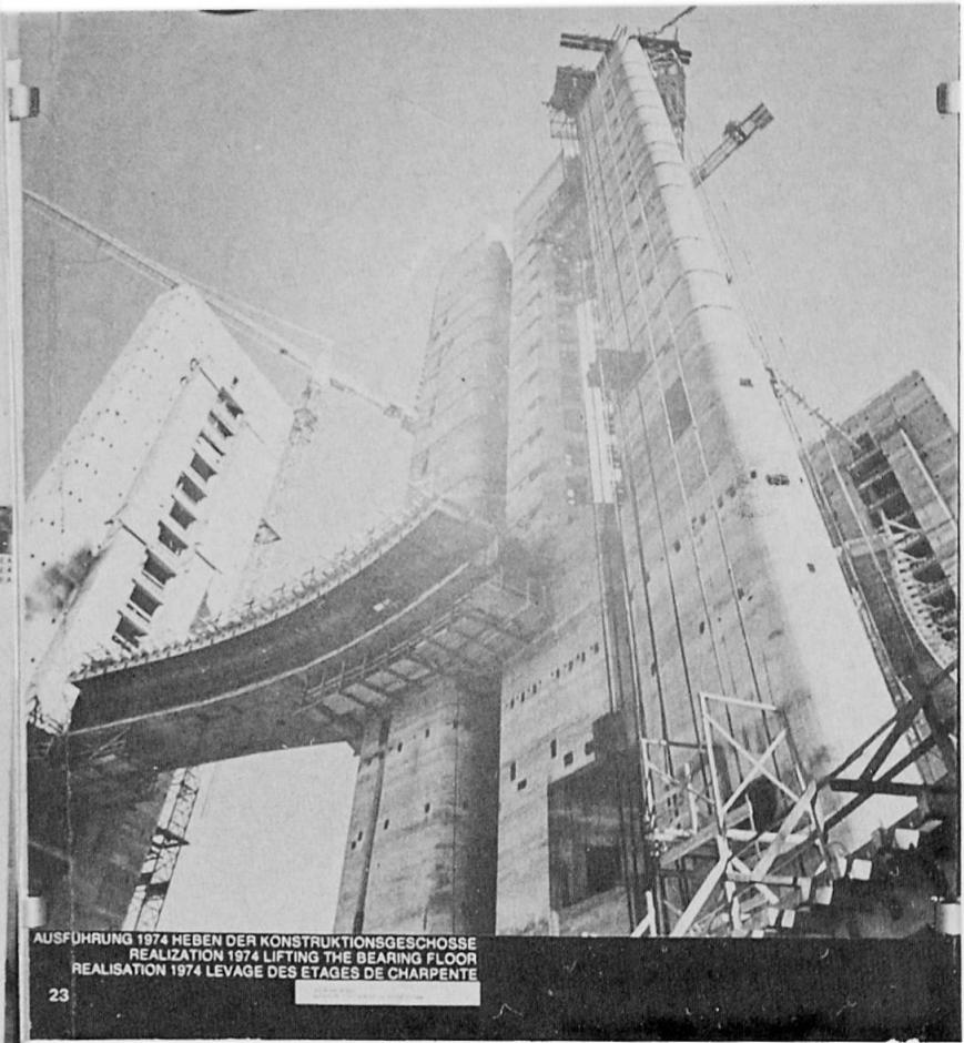
AUSFÜHRUNG 1974 HEBEN DER KONSTRUKTIONSGESCHOSSE
