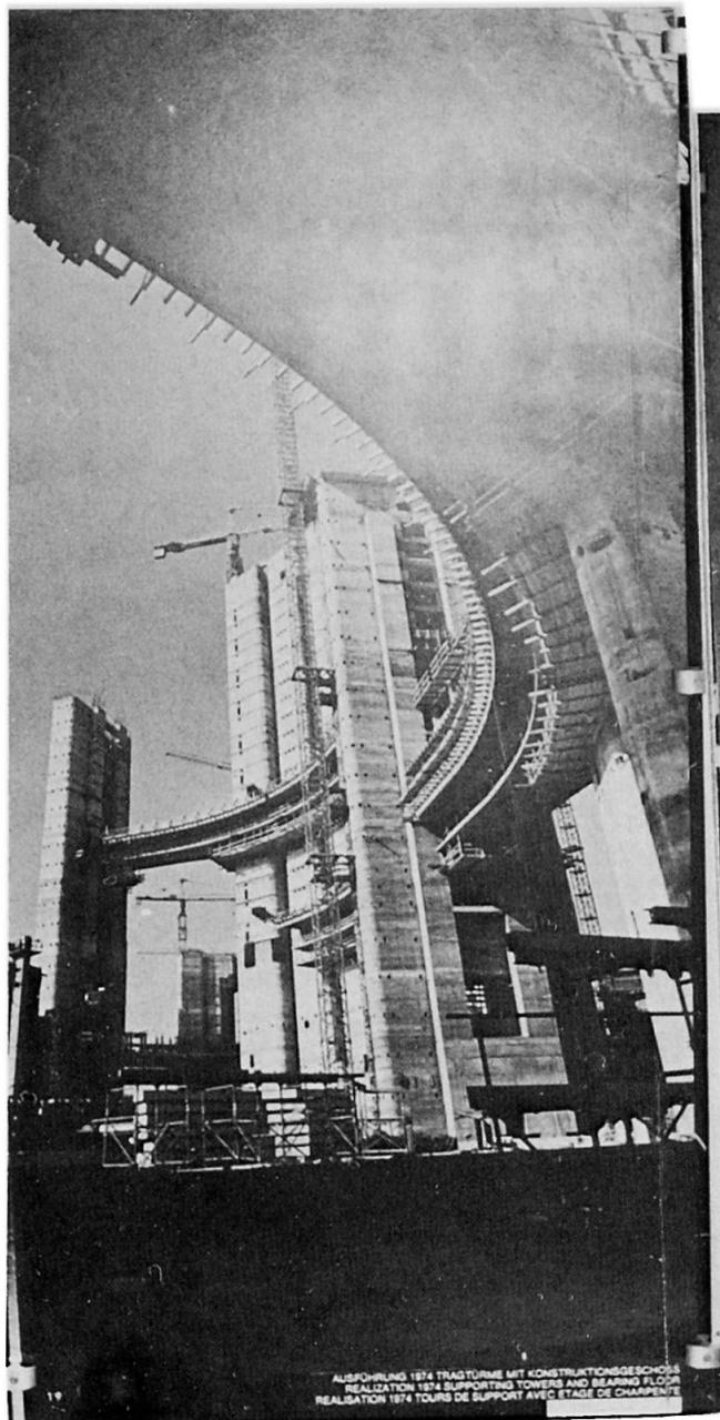
AUSFÜHRUNG 1974 TRAGTURME MIT KONSTRUKTIONSGECHOIS
