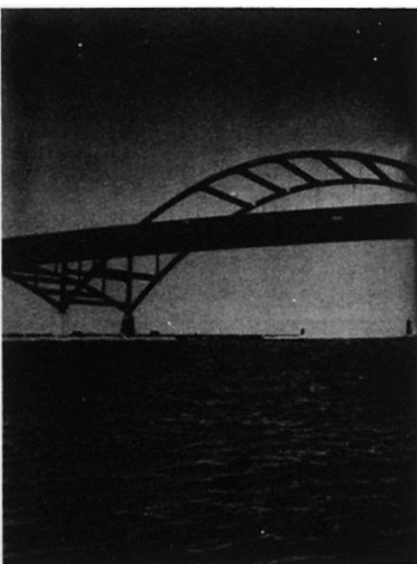
Pont de Milwaukee
