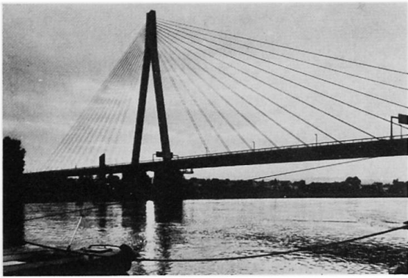
Pont de Raiffeisen
