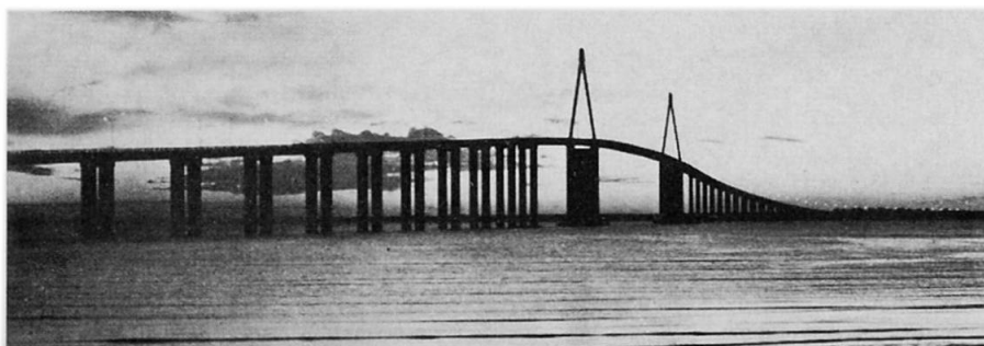
Pont de Saint-Nazaire
