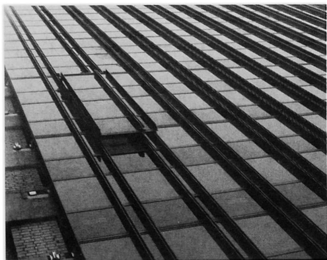
Bild 2 Aufziehen eines zwei Geschoss hohen Fassadenelements
